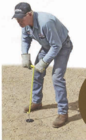
Introduceti carligul de blocare al ancorei prin bucla de la capatul cablului.
